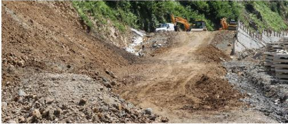
სურ: 4. ავტომაგისტრალის მშენებარე მონაკვეთი, ვაკისი ეწყობა ადგილზე არსებული გრუნტით.
