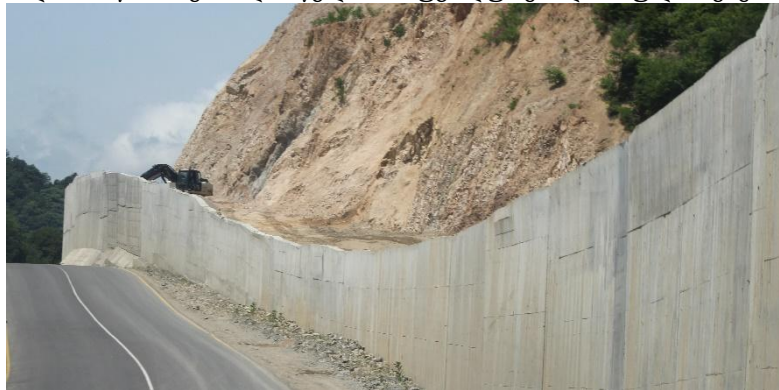
სურ: 5. ავტომაგისტრალის გასწვრივ დამცავი ბეტონის კედელი.
